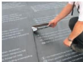
Im Bereich der Längsnähte wird so eine kraftschlüssige Verbindung geschaffen.
