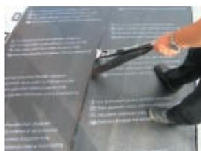
Im Bereich der Quernähte werden die Bahnen ohne Überlappung dicht gestoßen verlegt. Die Oberseiten werden hierbei mit **Anschlussband** verklebt und durch Andrücken funktionssicher geschlossen.
