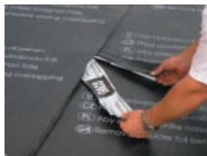
Im Anschluss werden die beiden silikonisierten Abziehstreifen zwischen den überlappenden Bahnrändern gleichzeitig entfernt. Die Längsnähte werden dann durch Andrücken dauerhaft und funktionssicher kaltverklebt.
