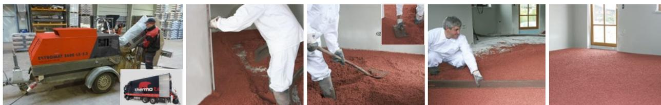
1 Sack (200 Liter) mit 10 - 12 Liter Wasser (je nach Produkt) in Estrichpumpe zu einer homogenen Dämmung mischen (mind. 2 Min. Mischzeit).
